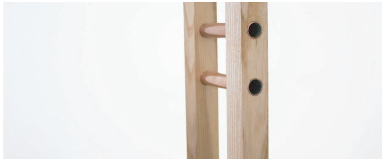
Obrázek 29 Detail spoje u němého sluhu (zdroj: vlastní)
