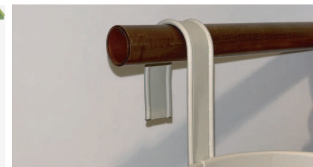
Obrázek 19 Upravený hák na rozměr trubky (zdroj: vlastní)
