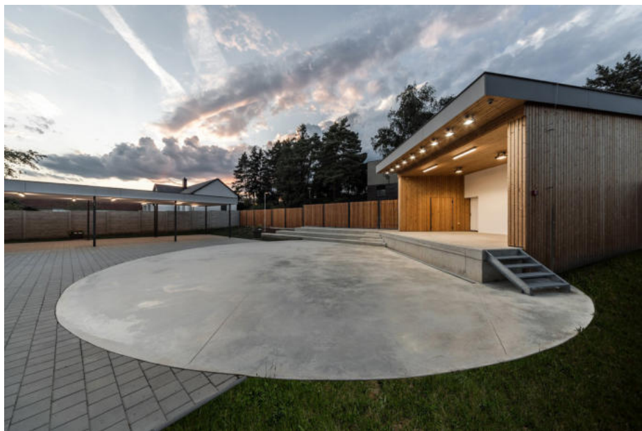
Športový a kulturný areál Školka v Nezdenicích Ateliér Mur, 2021
